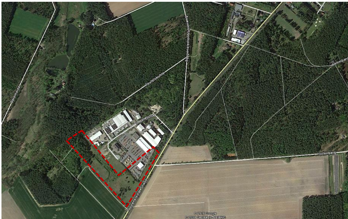
Abbildung 1: Luftbild vorhandene Situation
